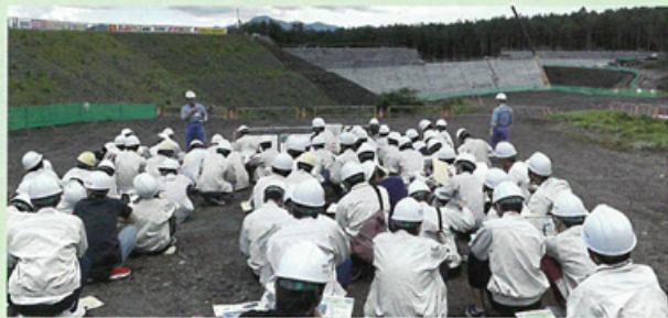
ハッ場ダムの現場見学(生産実習)
