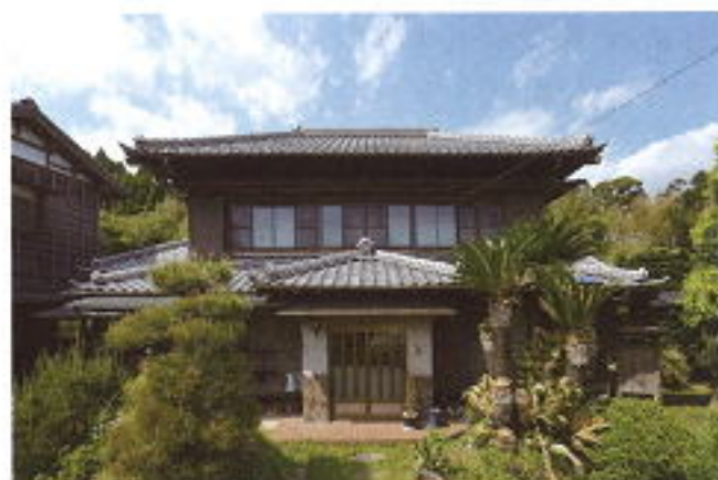
現在工事中の大多喜町の築130年の古民家
