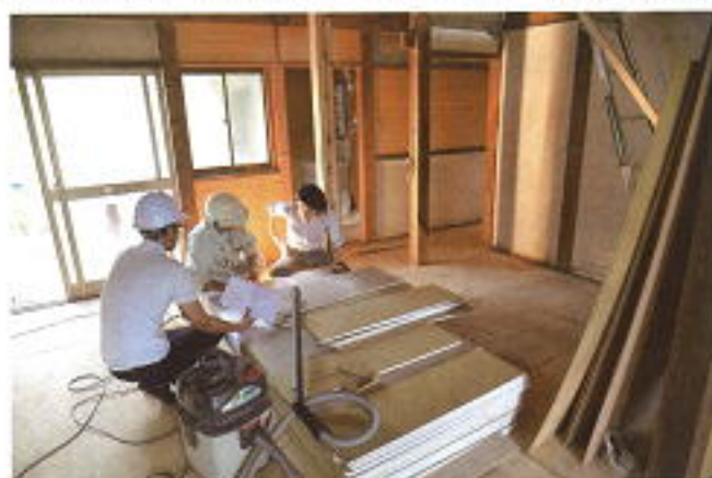
工事打ち合わせ風景(居住コース出身のスタッフと現場監督と職人)
