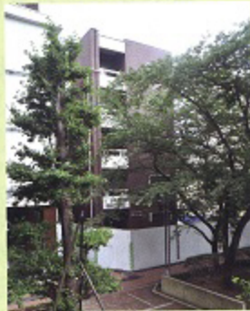
解体工事が開始された3号館
