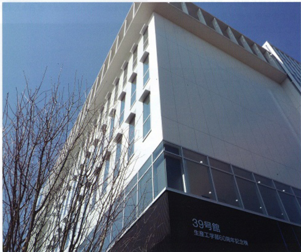
39号館生産工学部60周年記念棟竣工
