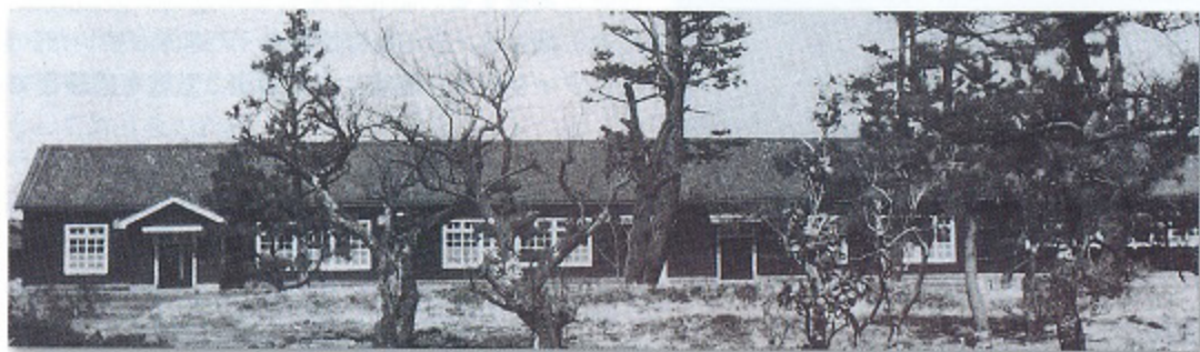
兵舎利用の教室棟
