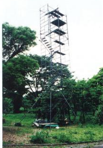
スカイカム用仮設カメラ台
